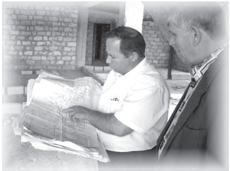
Строительство первого офиса СЦ ХВЕ Молдовы.
